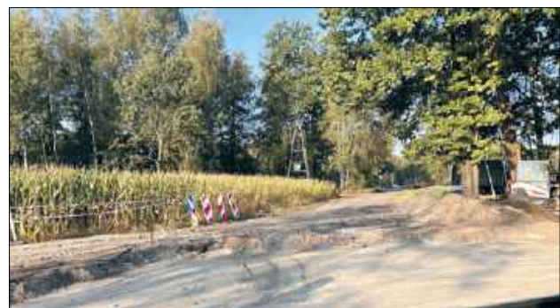
Przy drodze wojewódzkiej 812 powstanie 6 nowych skrzyżowań
