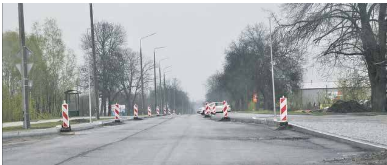
Ostatni odcinek ul. Warszawskiej miał być gotowy na początku listopada 2020 roku. Prace wciąż trwają...
