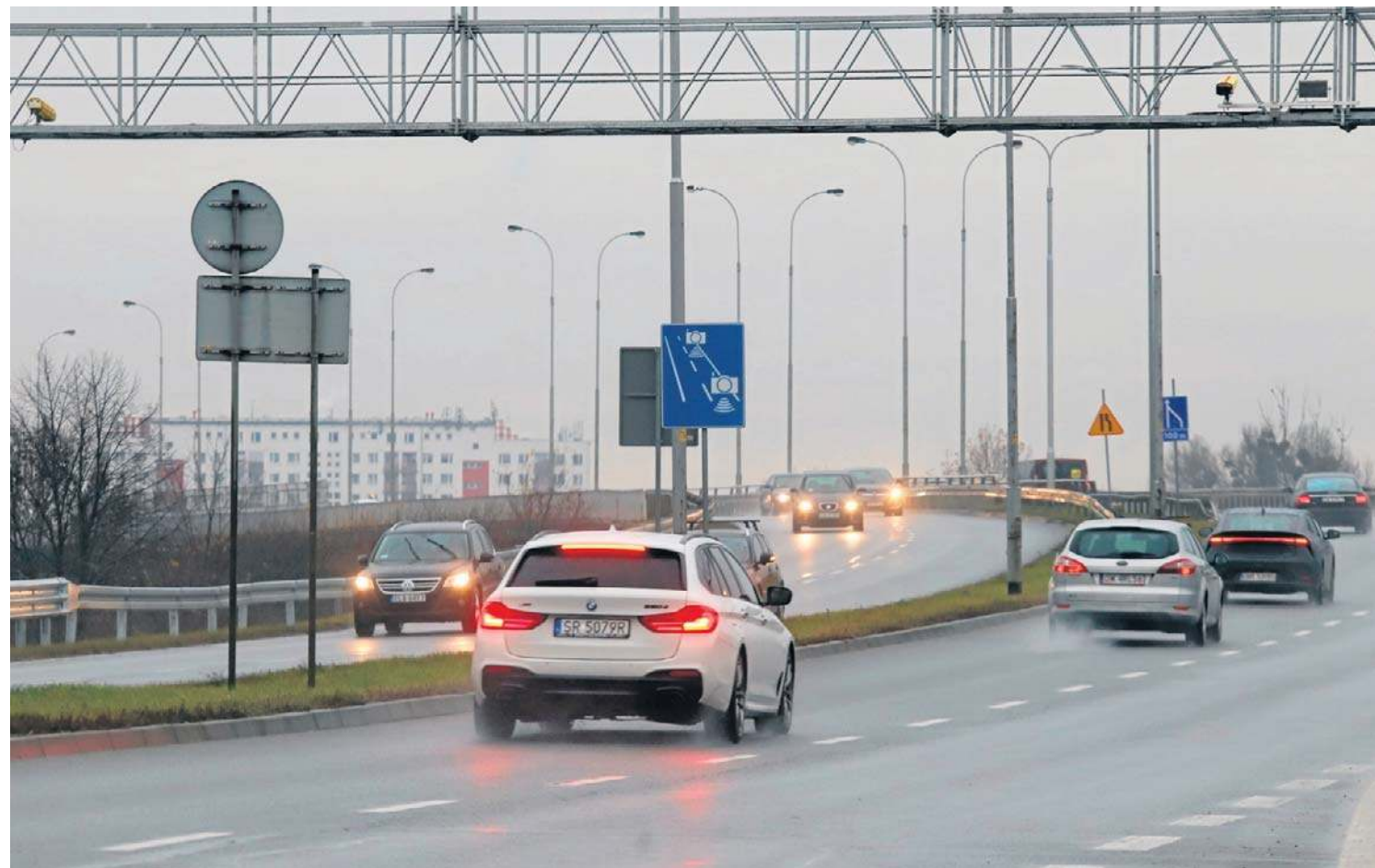
Na polskich drogach trwa instalacja 43 nowych systemów odcinkowego pomiaru prędkości. To część większego projektu, który zakłada wdrożenie łącznie 117 urządzeń na drogach krajowych, w tym na autostradach i trasach ekspresowych
