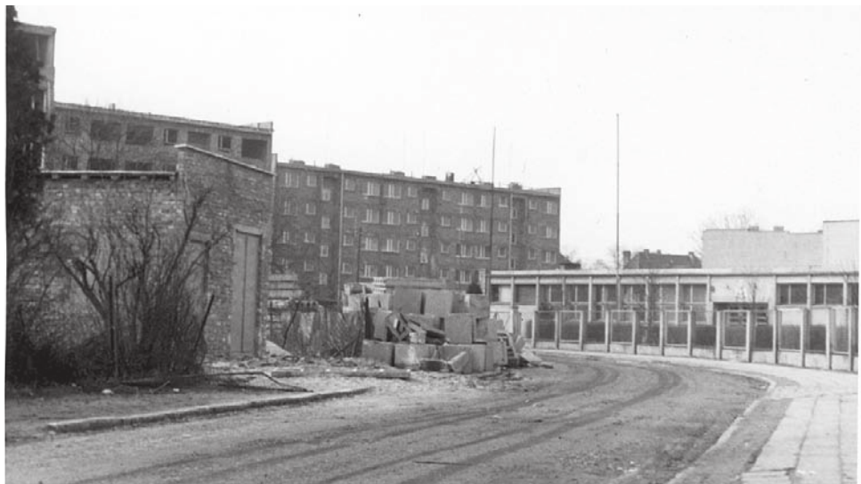
Zdjęcie nr 8 pochodzi z albumu Waldemara Stawarskiego, a zrobiono je w latach sześćdziesiątych - na zdjęciu nowa szkoła nr 5 przy ulicy Kamiennej
