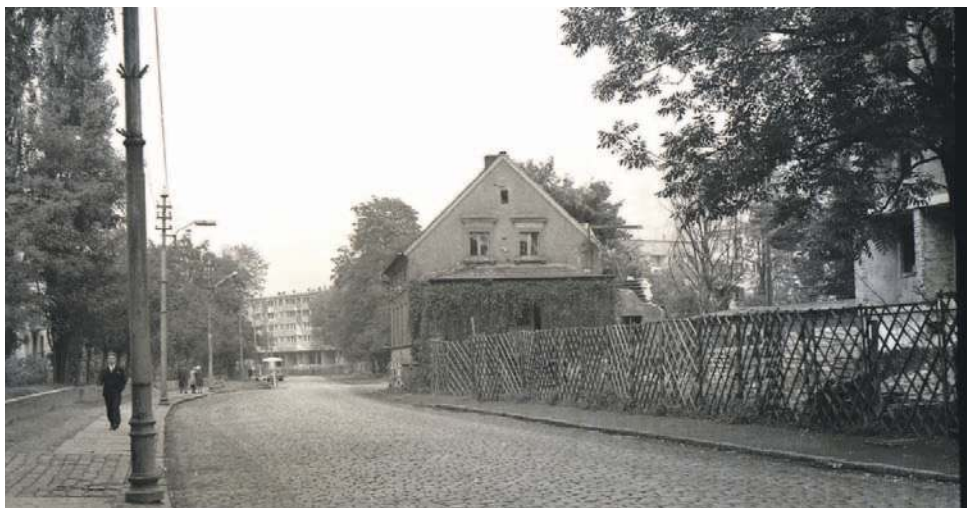
Zdjęcie nr 3 zrobiłem w 1967 roku, po prawej w budowie budynek SM Odra, na wprost budynek w trakcie rozbiórki, na którym według Jerzego Witkowskiego wisiała atrapa pocisku. W głębi w budowie budynek mieszkalny z placówkami handlowymi „na deptaku”
