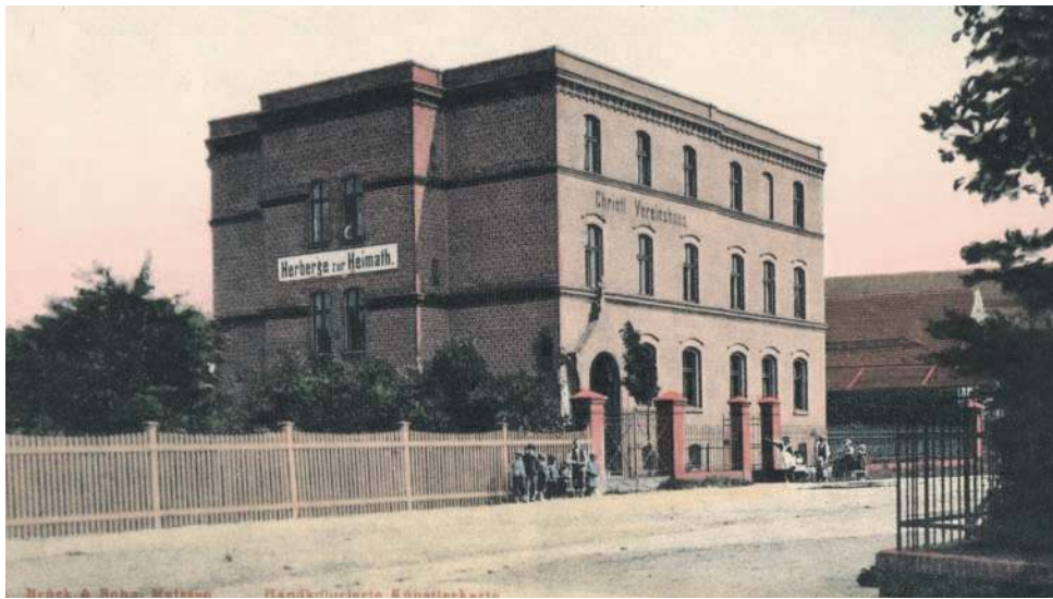
Zdjęcie nr 1 - przedwojenna widokówka, na której widzimy budynek przy dzisiejszej ulicy Kamiennej 4
