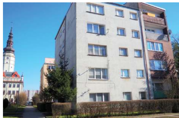
Blok przy ul. Książąt Brzeskich w Strzelinie
