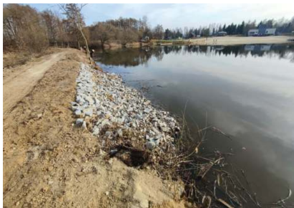
Newralgiczne miejsce wału dolnego stawu. Wcześniej doszło tu do przesiąkania wody, a fragment ten był zabezpieczony workami z piaskiem
