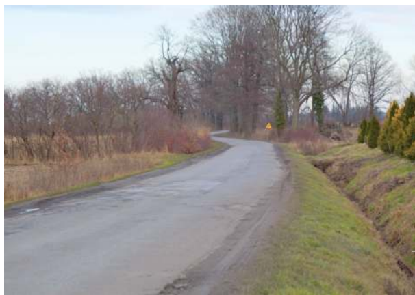
Droga relacji Prusy – Gołostowice zostanie przebudowana
