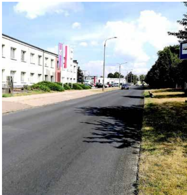
Zakończyły się prace związane z wymianą nawierzchni na ulicy Nasiennej
