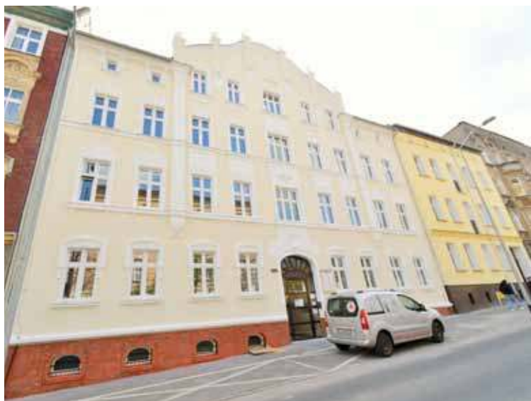
Kamienica, w której swoją siedzibę ma Polski Czerwony Krzyż przeszła gruntowny remont
