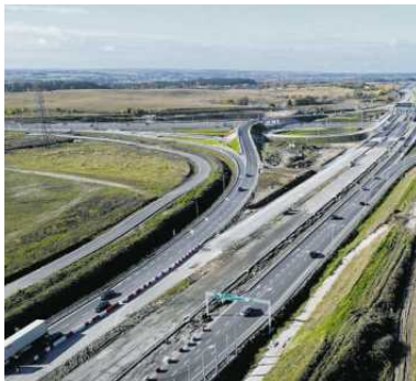
• Obwodnica Metropolii Trójmiejskiej ma być w całości przejezdna jeszcze w 2025 roku. Na zdjęciu przebudowany węzeł Gdańsk Południe FOT. GDDKiA
