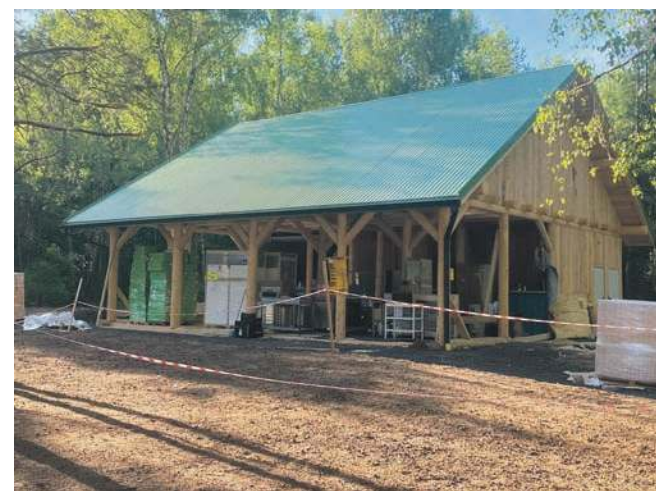
Tak wygląda budynek przyszłej restauracji nad Balatonem
