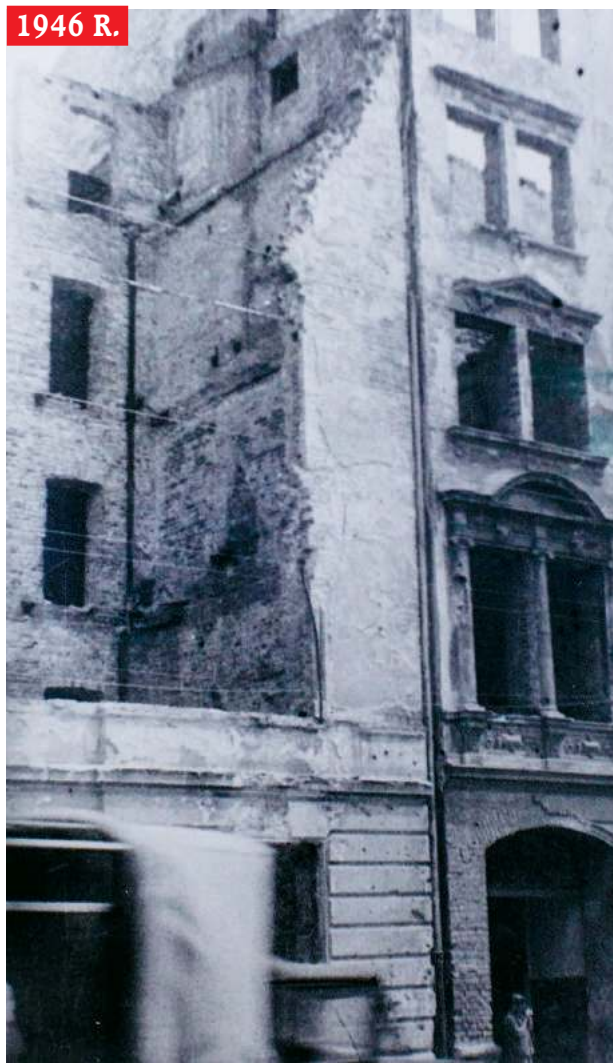
Rozebrana kamienica przy ul. Towarowej 64 i fragment domu nr 62 w 1946 r. Akta BOS. Zbiory Archiwum Państwowego w Warszawie
