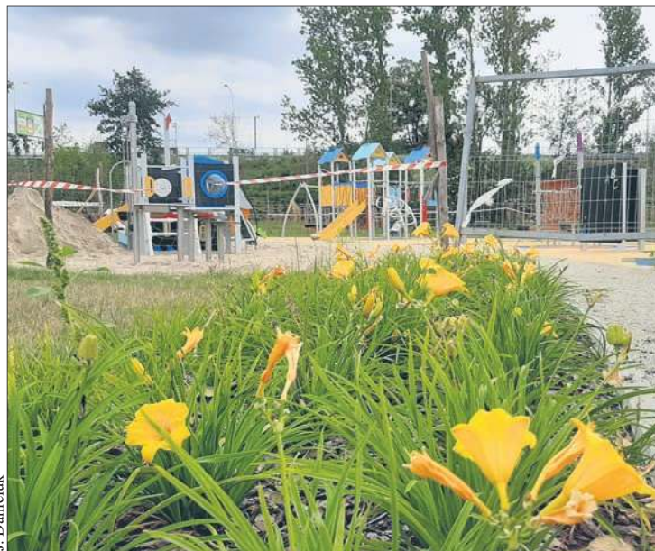
Trwa budowa parku w Radziwiu
