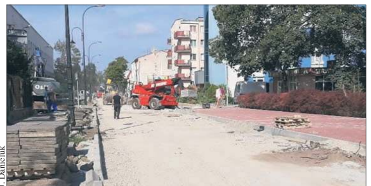
Wzdłuż remontowanego fragmentu ulicy 3 Maja są już gotowe miejsca parkingowe
