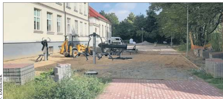
Trwa budowa placu zabaw przy Szkole Podstawowej nr 14 przy Al. Jachowicza 20
