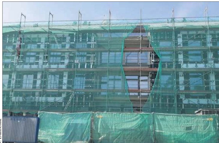
Trwa odbudowa kamienicy przy ul. Królewieckiej 18
