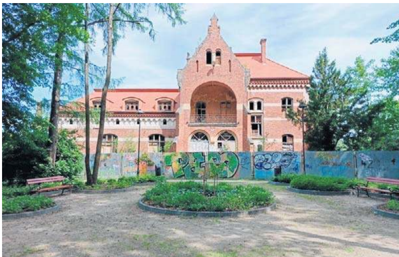
Zaniedbany zabytek w Krośnie zostanie przebudowany
