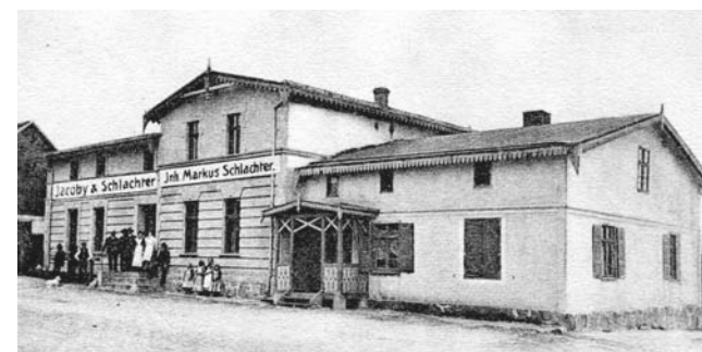
Karczma w Łąkorzu, której budynek stoi do dzisiaj
