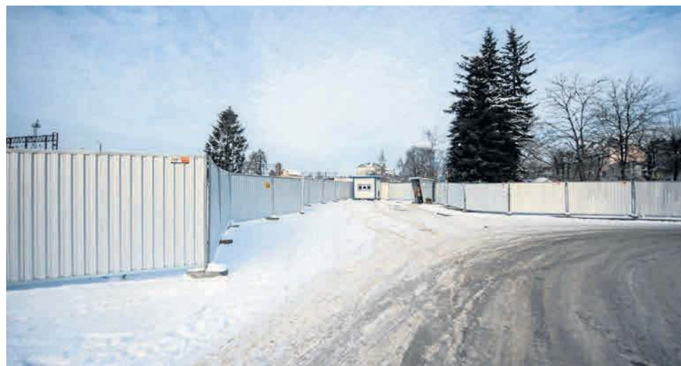
Teren w pobliżu dworca kolejowego (i po sąsiedzki z wiatą autobusową) jest już ogrodzony
