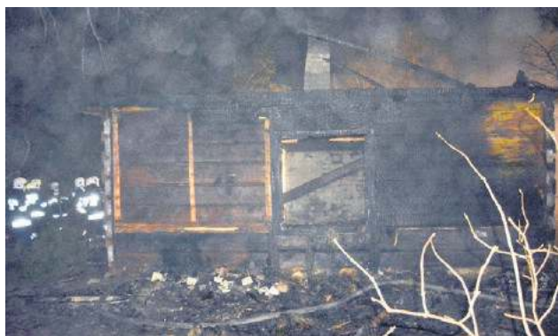
Ogień doszczętnie strawił drewniany dom. Fot. KM PSP Zamość
