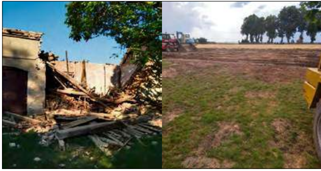
Zawalona stodoła została rozebrana, a teren uprzątnięty.
