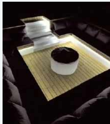
📌 Taśmy LED zamontowano pod siedziskami we wgłębniku.
