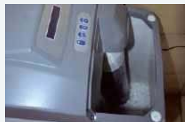
2 Wewnątrz zmiękczacza znajduje się kolumna ze złożem żywicowym.
