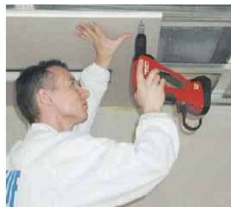
📍 Mocowanie płyt g-k do dwupoziomowego rusztu krzyżowego. KNAUF
