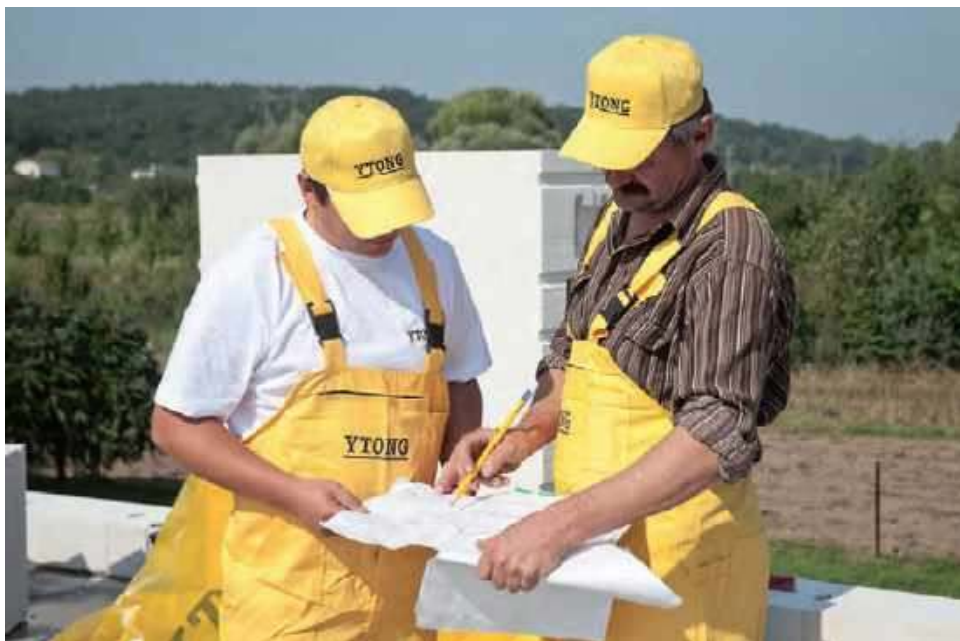
🔗 Wznoszenie ścian jednowarstwowych to przede wszystkim działanie ściśle według wytycznych producenta danego systemu. XELLA (YTONG)
