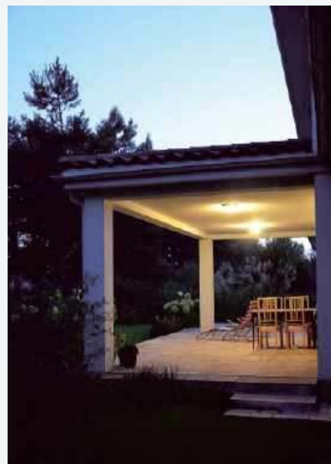
Nad tarasem – plafonierzy ze świetlówkami kompaktowymi 14 W.
