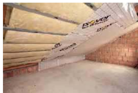
📍 Przy wykańczaniu skosów poddasza nie można zapomnieć o ułożeniu pomiędzy ociepleniem a płytami g-k folii paroszczelnej, która zapobiega kondensacji pary wodnej w warstwie ocieplającej i chroni konstrukcję dachu przed zawilgoceniem. ISOVER
