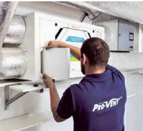
🔧 Montaż filtra antysmogowego. PRO-VENT
