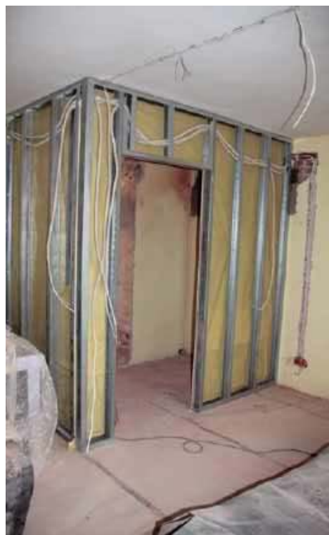
📍 Wnętrze ścian szkieletowych to idealne miejsce na poprowadzenie rozmaitych instalacji. J. WERNER
