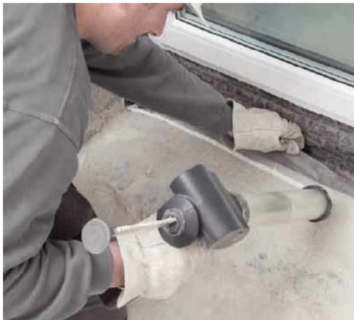
🔧 Montaż warstwowy wymaga starannego przygotowania podłoża. Inaczej nie da się dobrze przykleić taśm. REHAU
