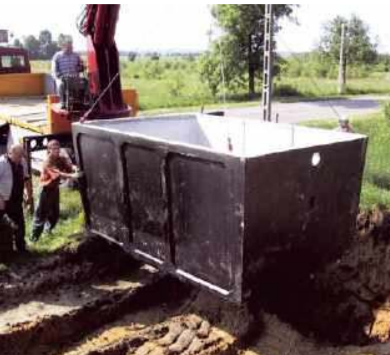
Duże zbiorniki podziemne z systemem wstępnej filtracji najczęściej wykonuje się z żelbetu. Są odporne na napór gruntu i wód gruntowych, nawet gdy są puste. GIZO
