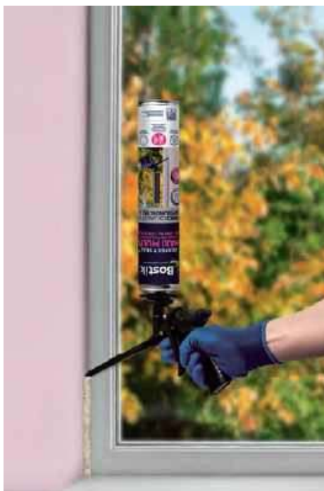
❷ Pianka rozprężna to dobry materiał uszczelniający, ale pod warunkiem, że zostanie starannie naniesiona i zabezpieczona przed wilgocią. BOSTIK
