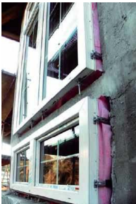
❶ Wysunięcie okien przed lico muru tak aby ostatecznie znalazły się w grubości ocieplenia ściany pozwala praktycznie wyeliminować mostek cieplny. VEKA
