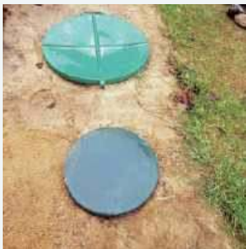
📍 Pokrywa zielona nad osadnikiem gnilnym i szara nad przepompownią.
