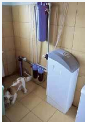
1 Rura wodociągowa, wodomierz, filtr mechaniczny, węglowy, zmiękczacz.
