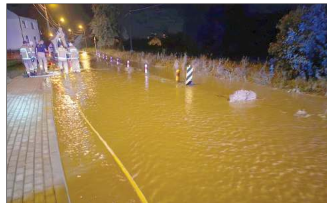
■ W powiecie raciborskim odnotowano liczne uszkodzenia domów i podtopienia.
