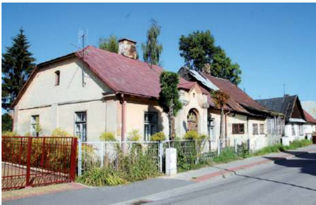
Ulica Spadek: stare domy, unikatowe drzwi, dawny młyn
