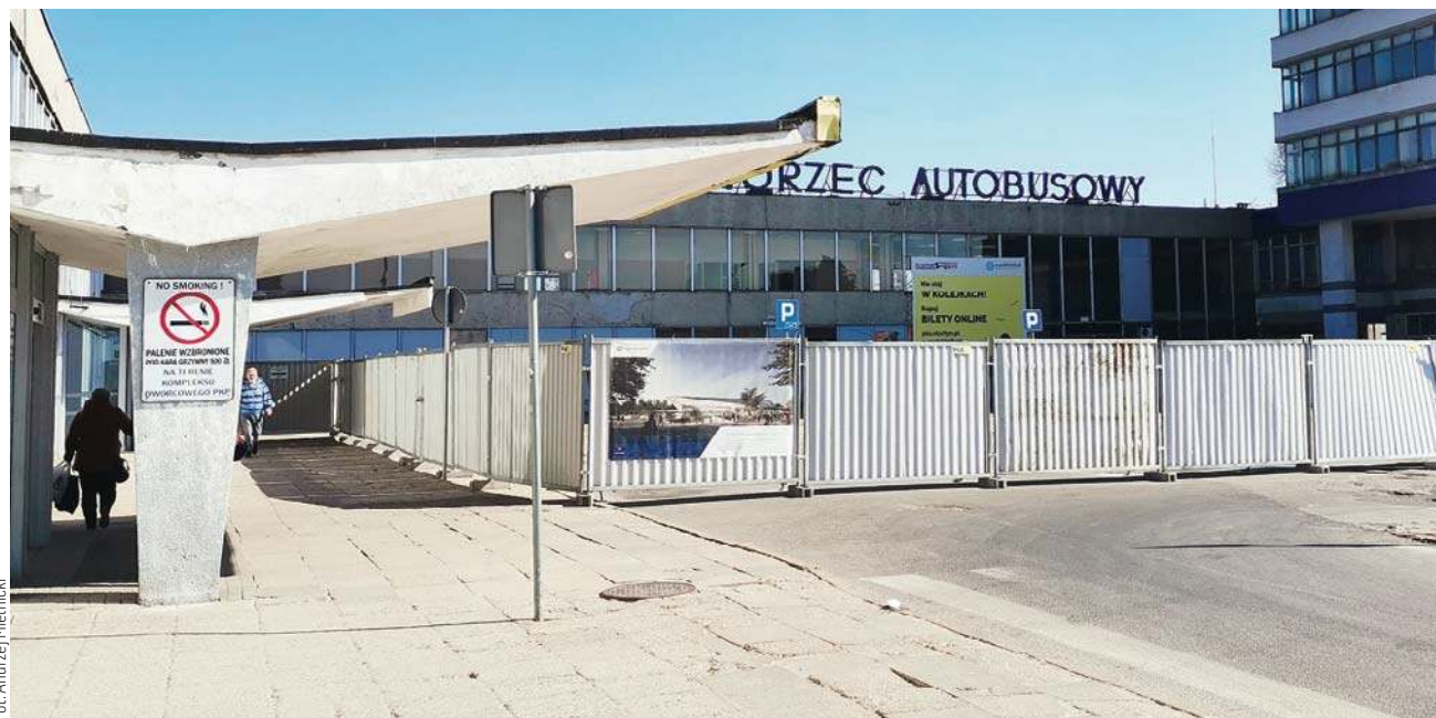
Na razie jedynym znakiem, że ruszyła budowa nowego dworca jest płot, który stanął wokół budynku
