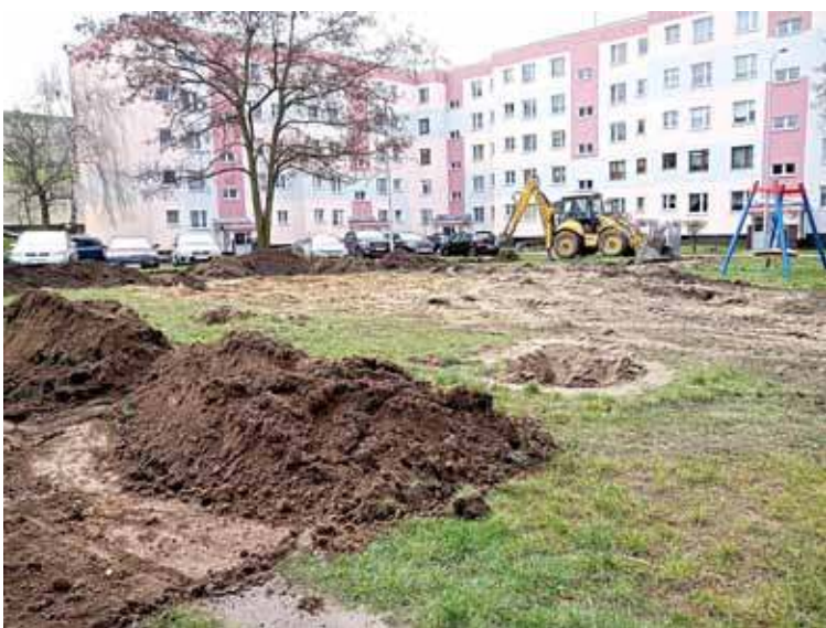
Rozpoczęła się budowa placu zabaw między ul. J. Przybosia i ul. S. Żeromskiego
