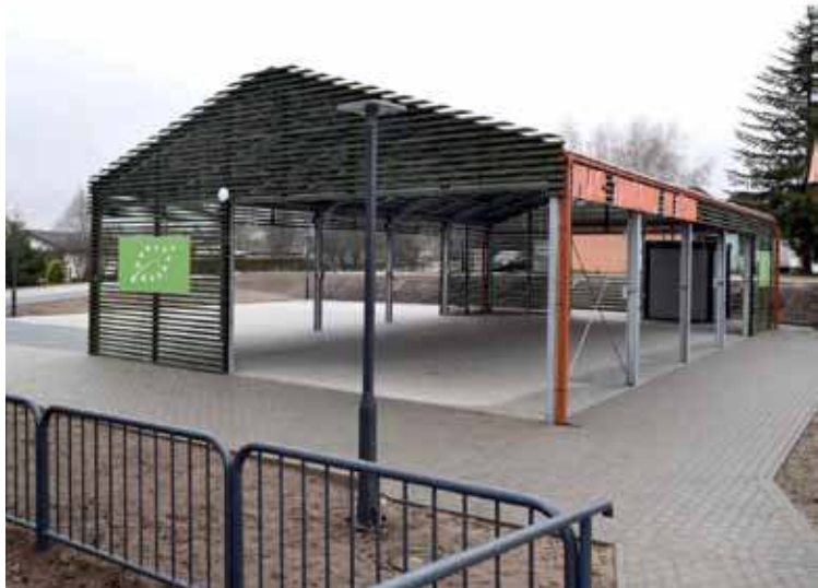
W ramach inwestycji wykonano również drogę dojazdową
