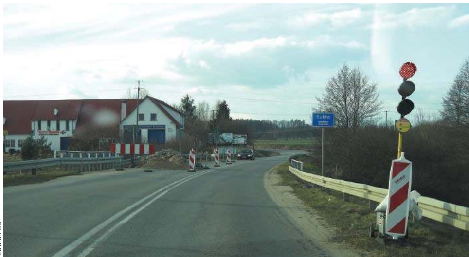
Ustawione przez drogowców znaki zmieniają położenie zgodnie z postępowaniem wykonywanych prac
