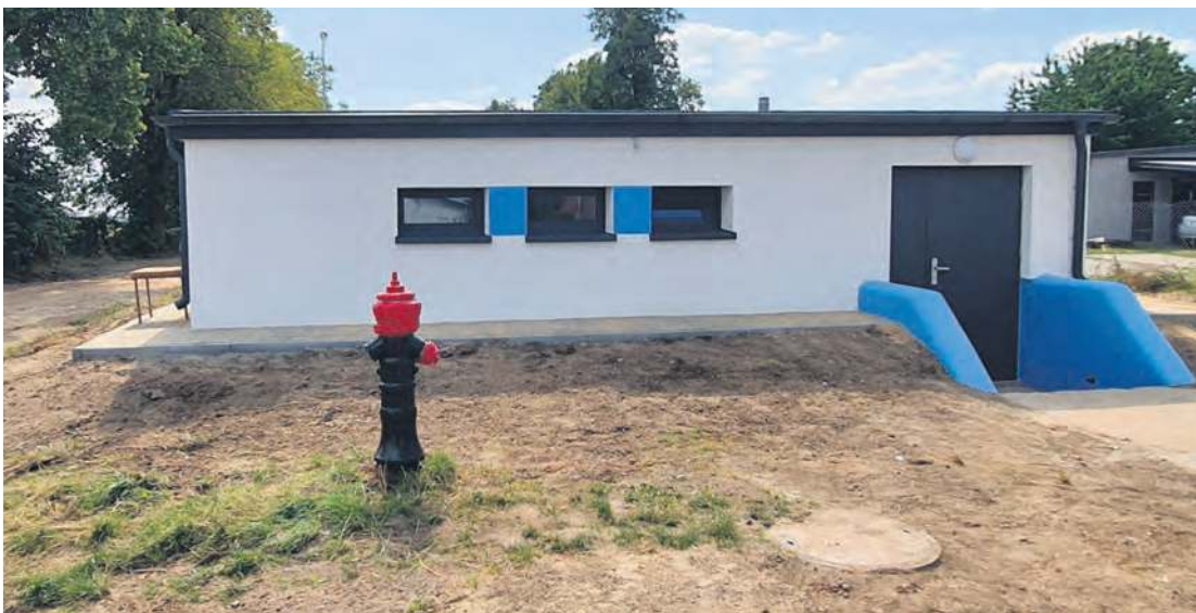
Po zakończeniu remontu lubiewskiej hydroforni gospodarka wodna, o której tak dużo mówiono w ostatnich latach na terenie tej gminy, wydaje się zabezpieczona. Fot. nadstawne
