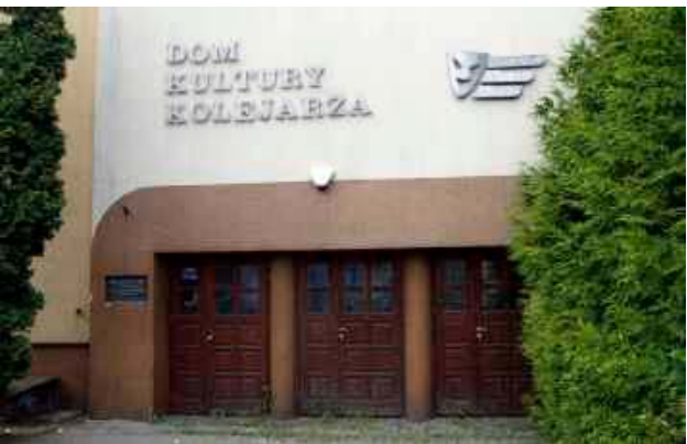
Były Dom Kultury Kolejarza, który miał się stać nową siedzibą Teatru Andersena, póki co stoi pusty i niszczeje
