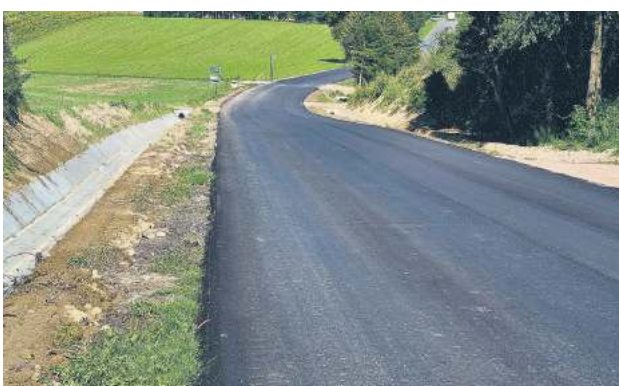
Przebudowana droga powiatowa relacji Kolonia Orłów Murowany - Stryjów z udziałem finansowym Miasta i Gminy Izbica
