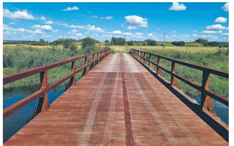
Wyremontowany most na rzece Wieprz, dzięki któremu można przejechać z Tarnogóry do Wału
