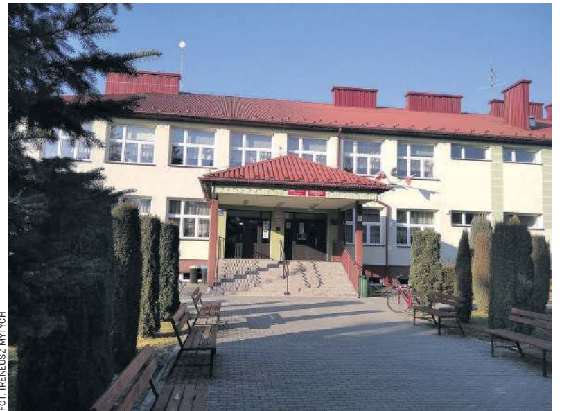
W ramach modernizacji energetycznej obiektów oświatowych prace remontowe zaplanowano m.in. w Zespole Szkół w Bojanowie
