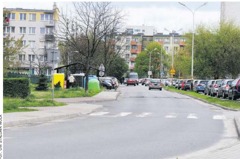
Przebudowie poddany zostanie odcinek drogi o długości 1434 metrów
