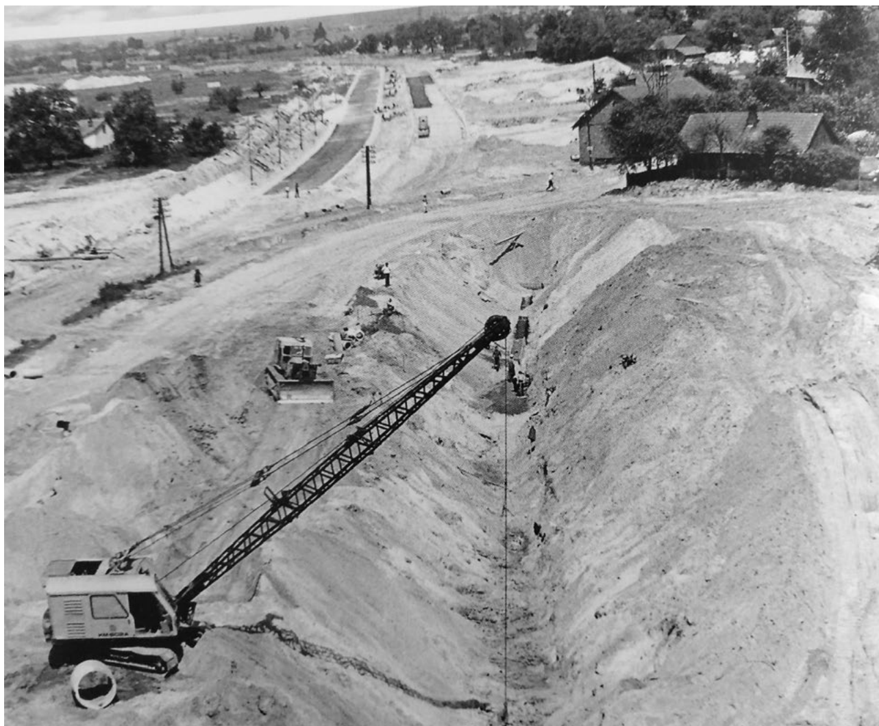
Budowa sieci wodno-kanalizacyjnej na trasie Stalowa Wola- Rozwadów, 1975 r., archiwum MZK Stalowa Wola
