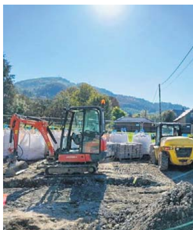
Trwa modernizacja, na placu budowy jest ciężki sprzęt
