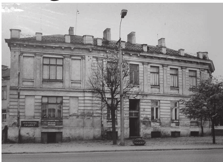
Mławska siedziba Selbstschutzu przy ulicy Żwirki (dziś kamienica ta zmieniła swój wygląd)
