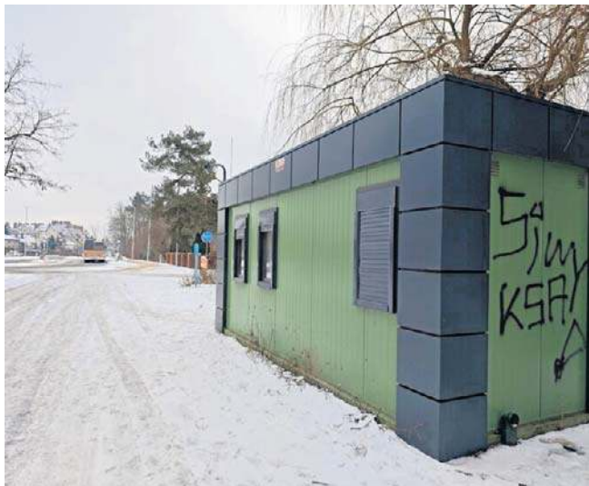
Na pętli przy Szosie Chełmińskiej przenośną sławojkę zastąpił kontener socjalny z toaletą i ciepłą wodą
