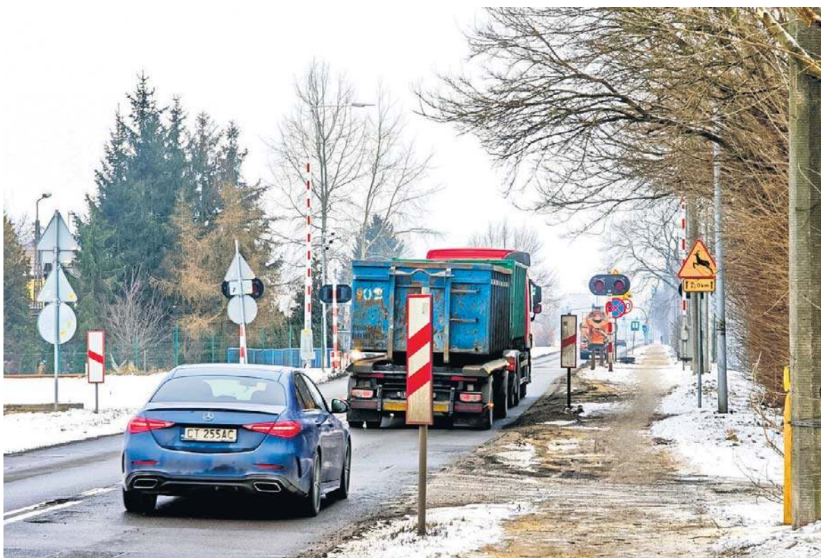
Umowa na przebudowę blisko 2-kilometrowego odcinka ulicy Olsztyńskiej została podpisana 22 października 2025 roku. We wtorek ruszyły pierwsze prace, które nie mają być zbyt uciążliwe dla kierowców
