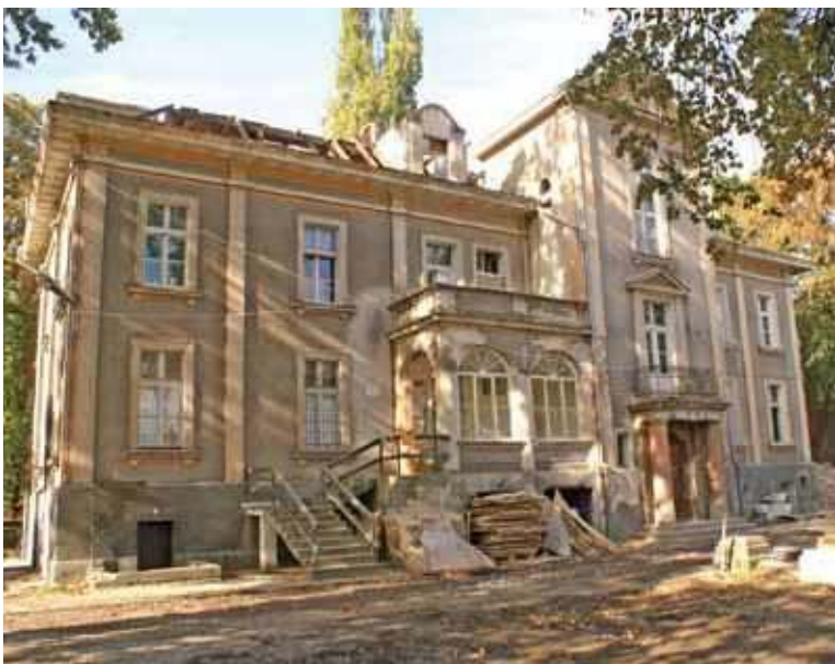
Dzisiejsza siedziba biblioteki w trakcie remontu
