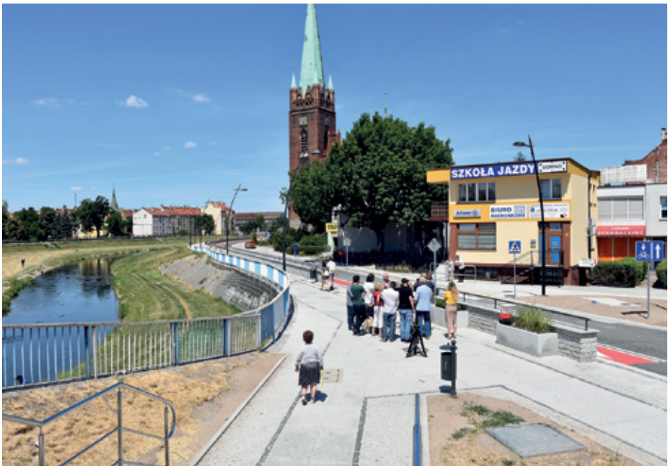
Bulwar nad Kaczawą został wybudowany w ramach rewitalizacji legnickiej dzielnicy Kartuzy
