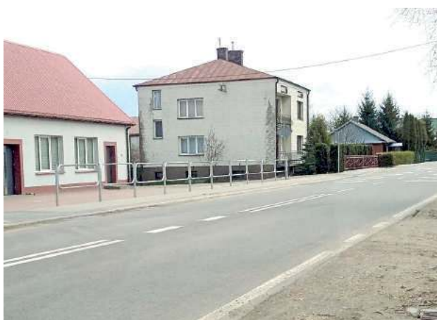
Droga powiatowa między Zofiborem a Sarnowem. Powiat zlecił jej wykonanie, a w kosztach miały partycypować gminy, przez które przebiega. Na razie swojej części dofinansowania dla powiatu nie przekazała gmina Wojcieszków
