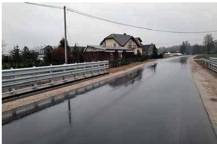
Nowa droga cieszy mieszkańców, otrzymujemy sygnały o porządnym wykonaniu tej inwestycji
