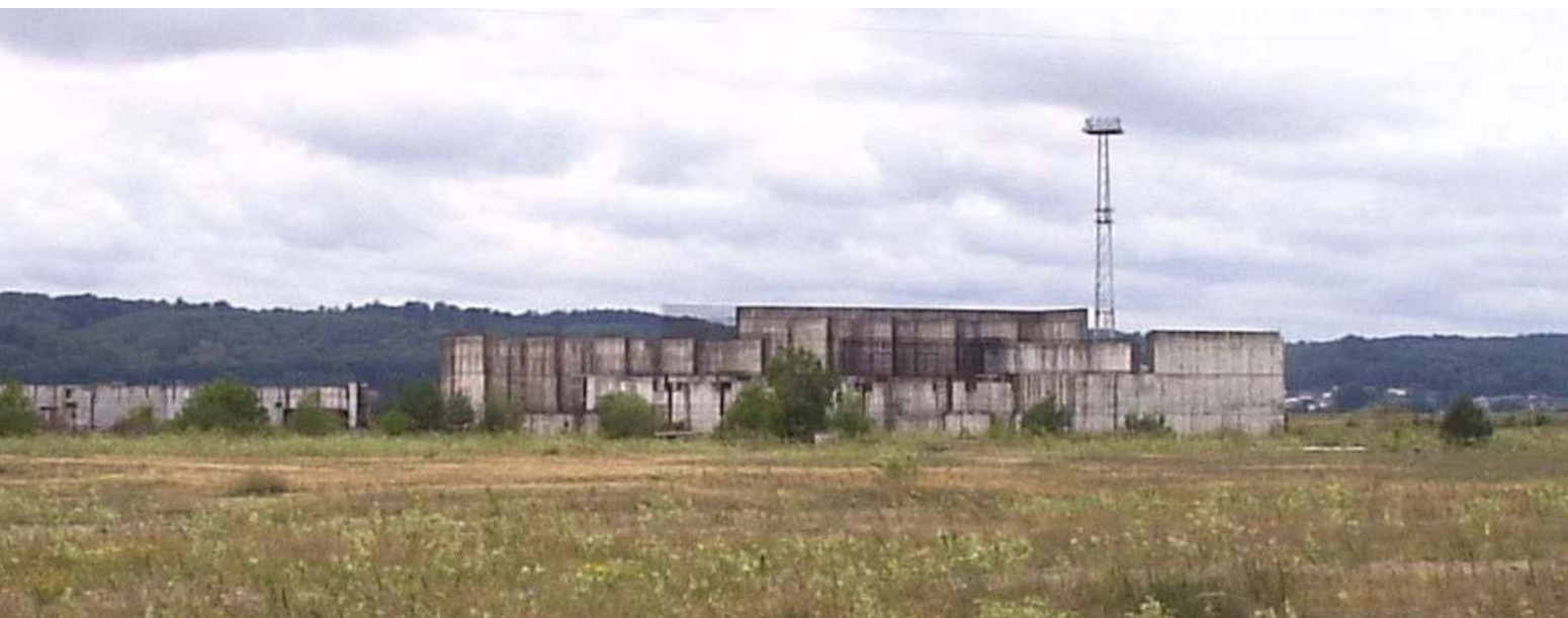
Pozostałości po niedokończonej elektrowni atomowej w Żarnowcu. Foto - wikimediacommons
