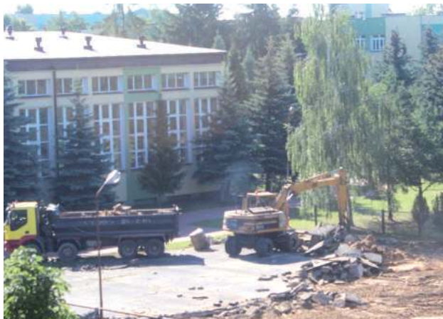
Z rozbiórką starego boiska poszło szybko
