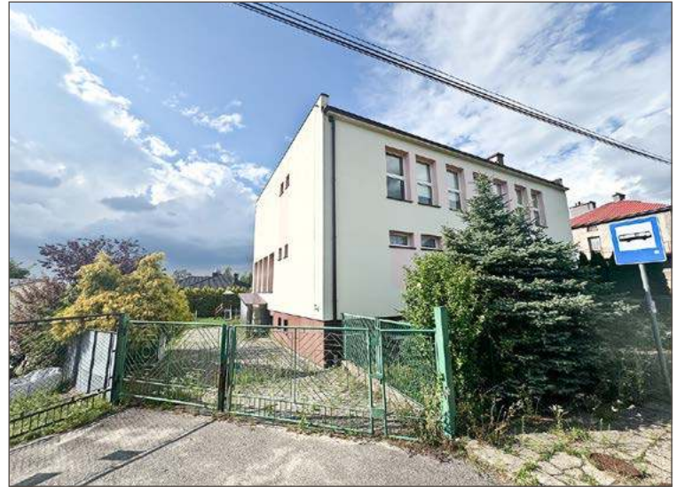
Plac znajduje się za budynkiem, w którym działała kiedyś SP nr 8.
