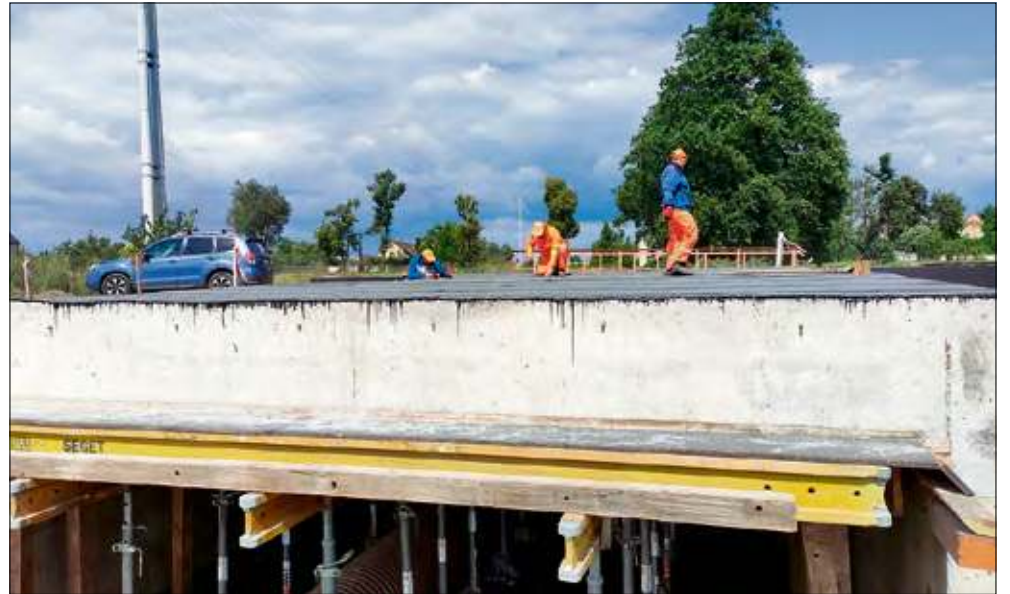
Wylano 60 metrów sześciennych betonu pod nowy most w Zielinie.
