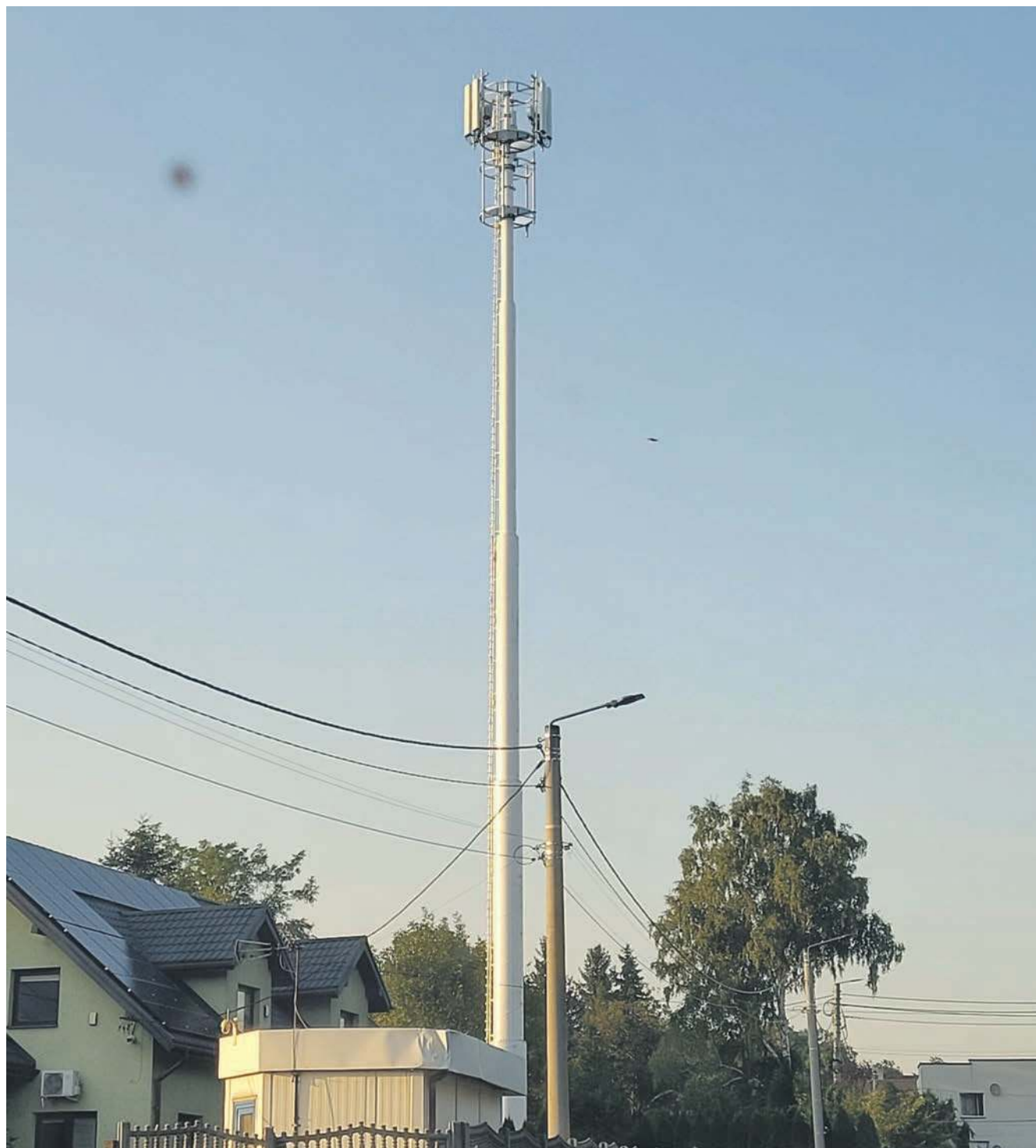
Nieopodal rafinerii i skrzyżowania ulic Dąbrowskiego i 1 Maja, stanęła stacja bazowa telefonii komórkowej Play nr CHR7114B wraz z instalacją elektroenergetyczną oraz kanalizacją kablową. Inwestycja posadowiona jest na działce nr 343/7 i części działki nr 343/9.
