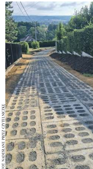
Ul. Głogowa w Tenczyńku po remoncie
