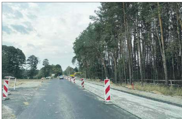
Najważniejszą, a tym samym najbardziej wymagającą inwestycją, jest rozbudowa drogi powiatowej w miejscowości Czosnówka. To ze względu na rozmiar prac, przewidzianych do wykonania
