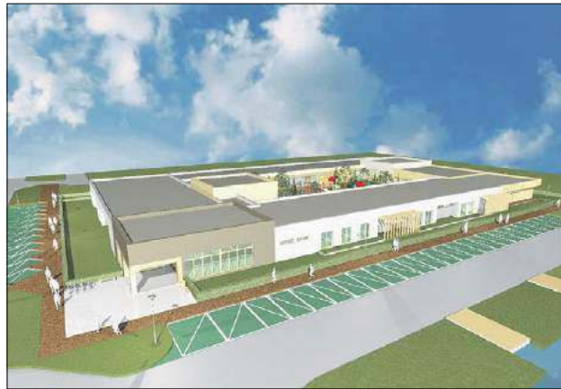
Do województwa lubelskiego ma trafić łącznie 2,74 mld złotych. Jedną z inwestycji z dofinansowaniem jest budowa przedszkola w Międzyrzeczu Podlaskim
