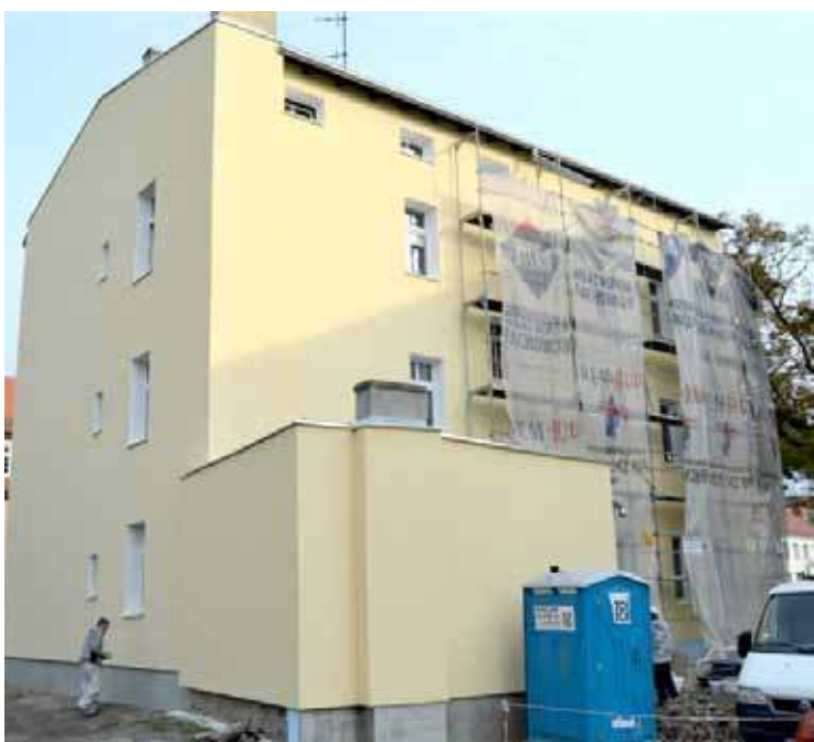
Efekt trwających prac remontowych będzie nowy wygląd kamienicy przy ul. Bogusława IV.
