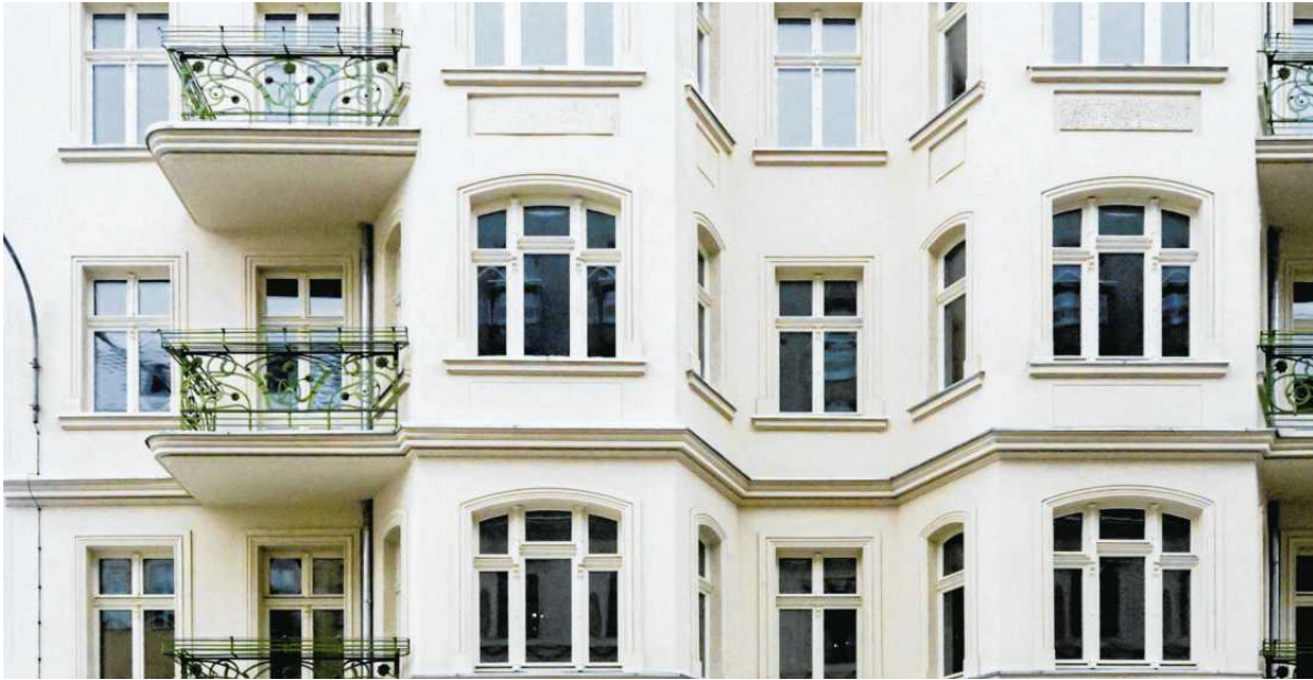
• Do wyremontowanej kamienicy lokatorzy wprowadzą się na początku przyszłego roku
