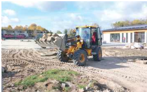
W Terespolu dobiega końca duża inwestycja obejmująca rewitalizację działek przy ul. Granicznej z targowiskiem miejskim, gdzie powstała hala i parking oraz budynek służący organizowaniu konferencji i altana
