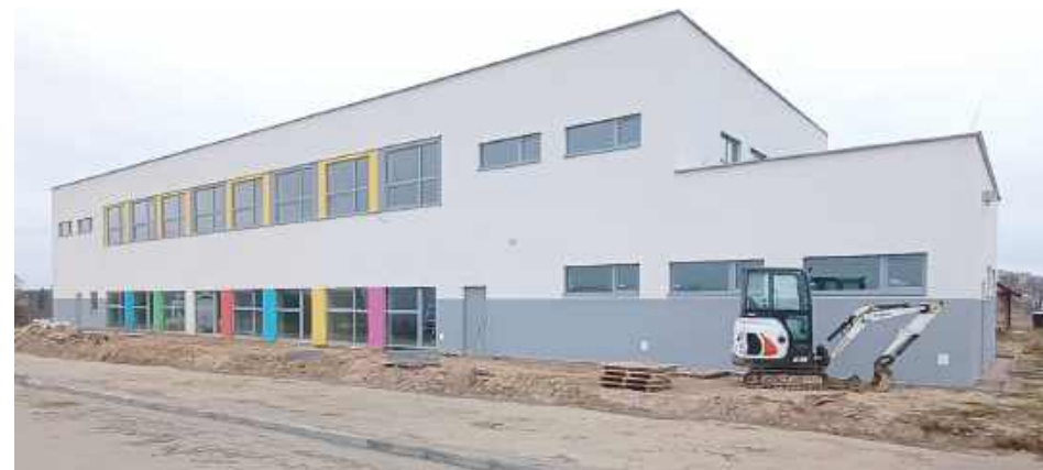
To pierwszy etap dużego projektu budowy SP w Nasutowie
