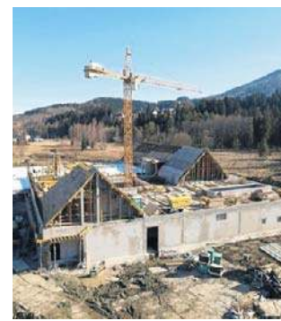
Budynek osiągnął już stan surowy
