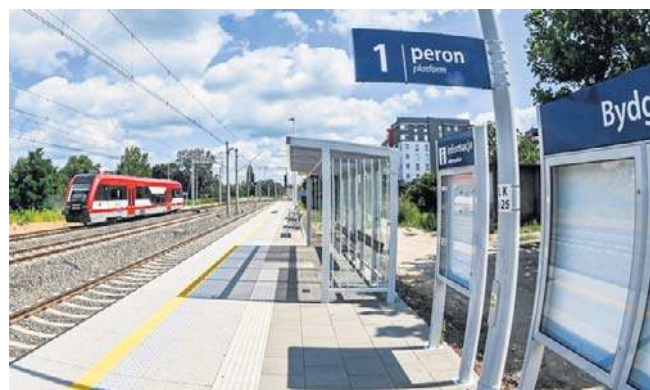
Na razie prace trwają na prostym odcinku. Roboty obejmą też skrzyżowanie ul. Gdańskiej i Kamiennej
