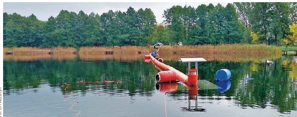
Zatapianie jednego rurociągu
