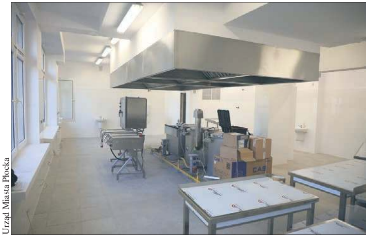
Nad wyposażeniem kuchni został zawieszony potężny okap. Żeby wnieść go do środka, trzeba było zdemonstrować jedno z okien
