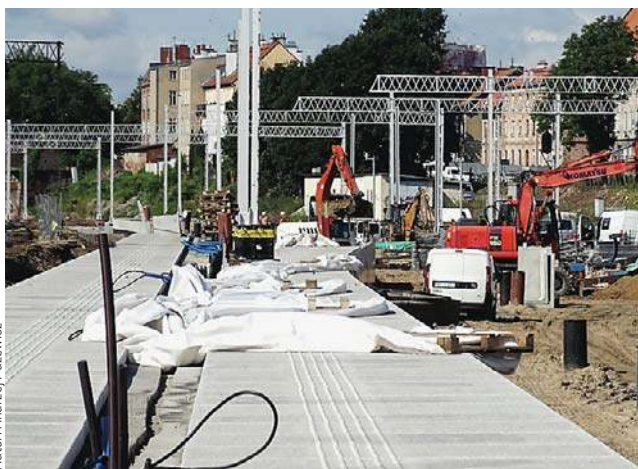
Nowa nawierzchnia na peronie 4
