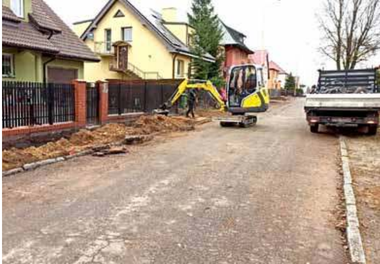
Rozpoczął się remont chodnika przy ulicy Szymanowskiego
